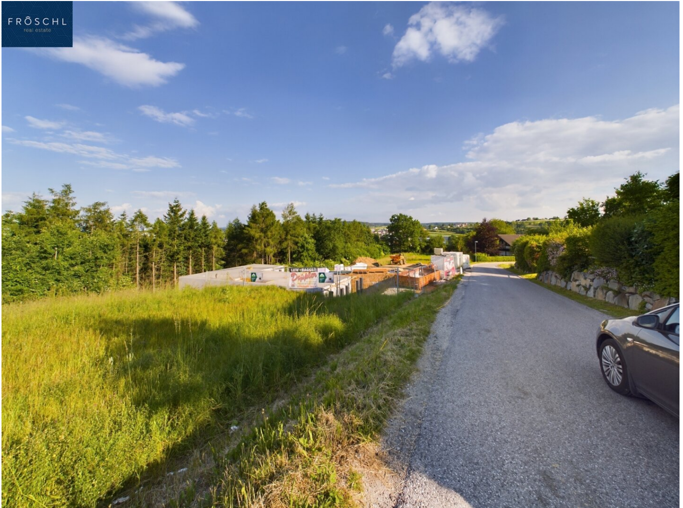
0 Allgemein Bauplatz Südhang Ansicht 1
