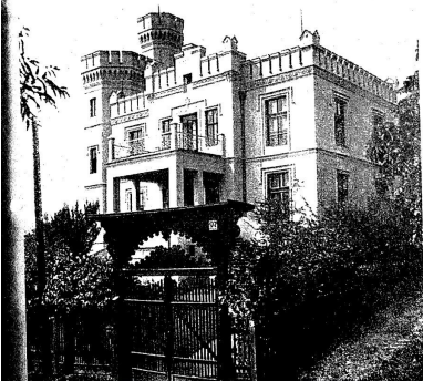
Inspiziert von den maurischen Burgen Südspaniens und Schloß Miramare bei Triest steht die im Volksmund "Ganserburg" genannte Villa der Familie Teurmer/Wiedermayer an den Hängen des Galltznberges. Bei der Errichtung der Villa wurden Elemente des ehemaligen, bei einem Großbrand zerstörten Ringtheaters miteingebaut. Das Gebäude ist von vielen Stellen aus sichtbar und ein strahlender Blickfang unter anderem aus dem oberen Teil der Thallestraße.
