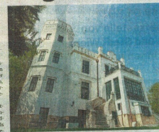
"Ottakringer Gansersburg": Das aufregendste Bauwerk am Willhelmsberg ähnelt dem Schloss Miramare in Triest.
