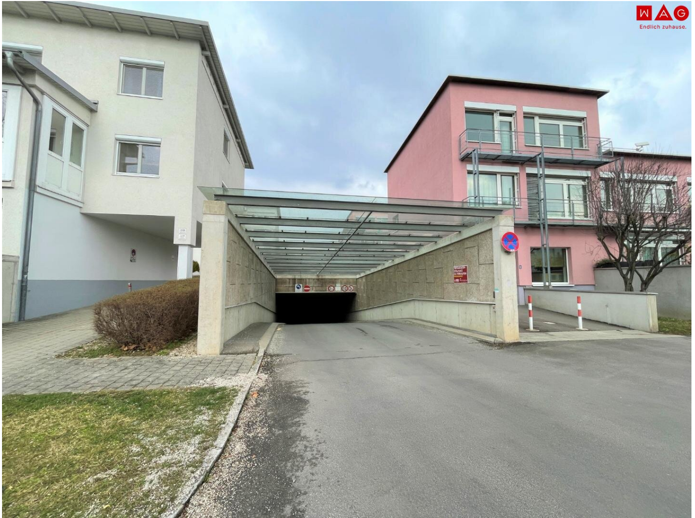
EBS Tiefgaragenabfahrt neu
